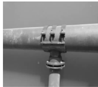
图 7 马鞍式管卡现场施工照片
